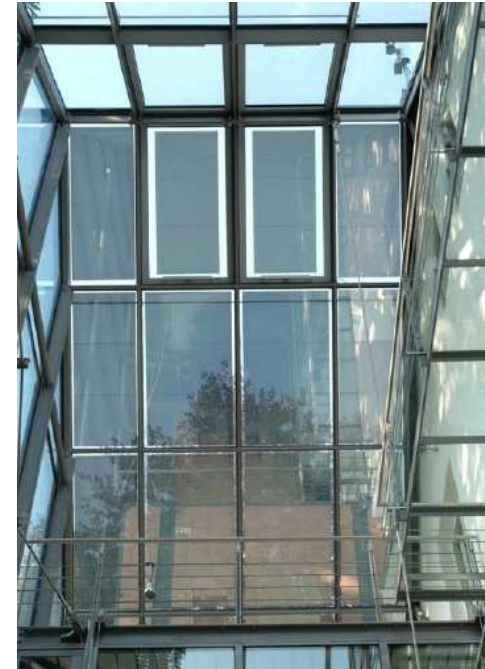
Difúzní rozptýlené světlo (tenkovrstvá FV amorfnní křemík)
