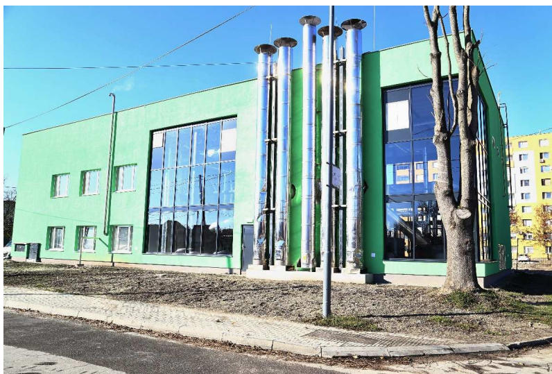
Obr. 7 Pohľad na zrekonštruovaný zdroj tepla - teplovodnej kotolne na zemný plyn
