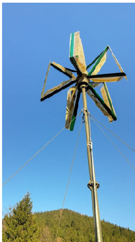
Obr. 9 Model větrné elektrárny Rolizo. Na sloupu 6 m kotvený 4 lany. Na snímku je ještě zavěšeno stavěcí lano.
