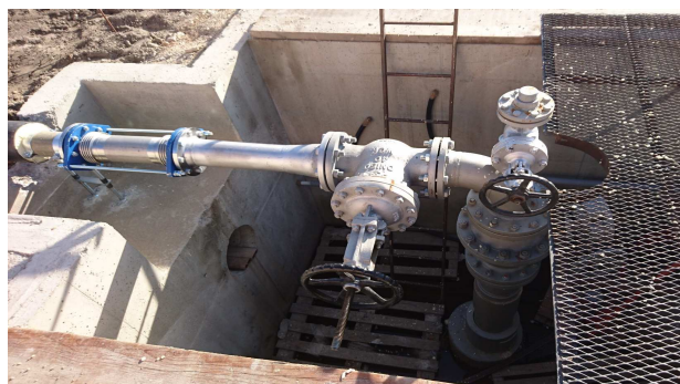
Obr. 1 Hlava geotermálneho vrtu VM-1 vo Veľkom Mederi
