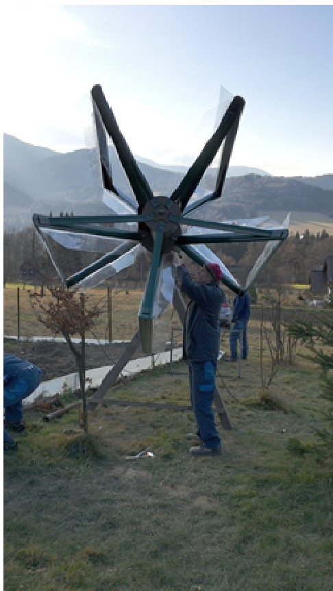
Obr. 7 Centrování lopatek, elektrárna ve sklopeném stavu
