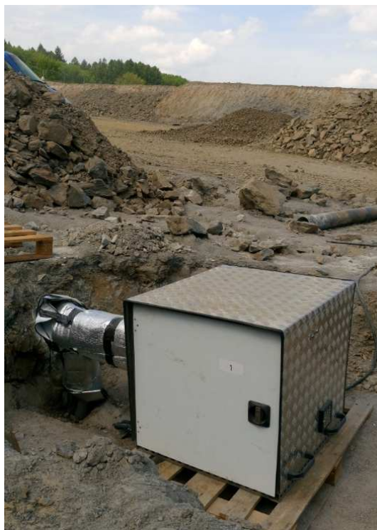
Obr. 2 Měřicí aparatura pro polní zkoušku tepelné vodivosti hornin – Thermal Response Test
