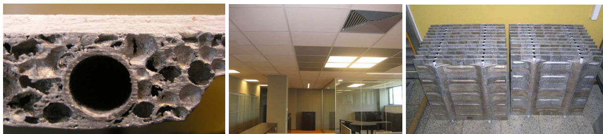
Obr. 3 Interiérové stropné vykurovacie/chladiace panely z penového hliníka v kancelárskych priestoroch (260 m 2 ) spoločnosti Sapa Profily a. s. v Žiari nad Hronom (Slovensko).
