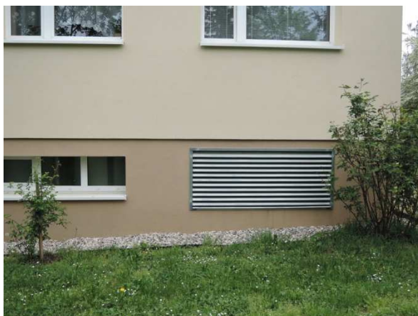
Obr. 3 Nasávání a výfuk tepelných čerpadel na fasádě Renoirova 622/5, Praha 5
