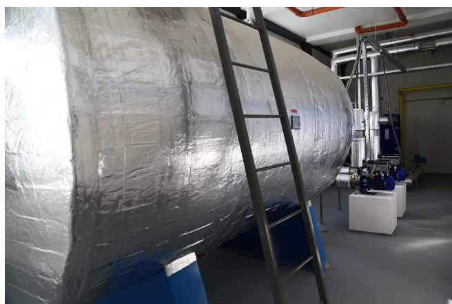
Obr. 4 Ležatá odplyňovacia a akumulčná nádrž s objemom 10 m 3
