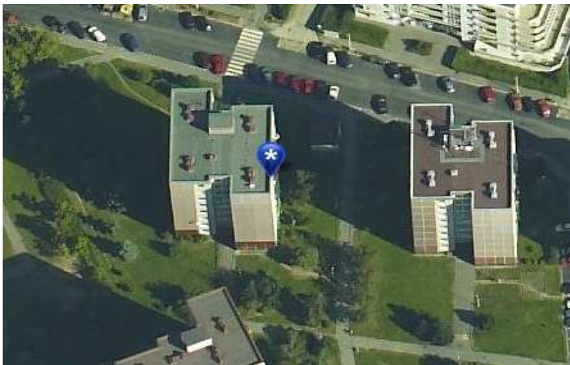
Obr. 1 Obytný panelový dům Renoirova 622/5, Praha 5
