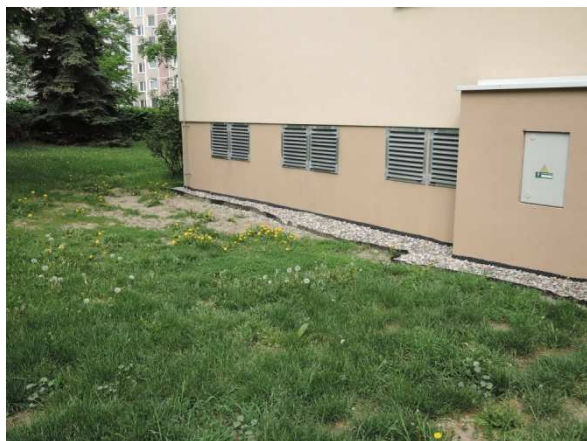
Obr. 3 Nasávání a výfuk tepelných čerpadel na fasádě Renoirova 622/5, Praha 5
