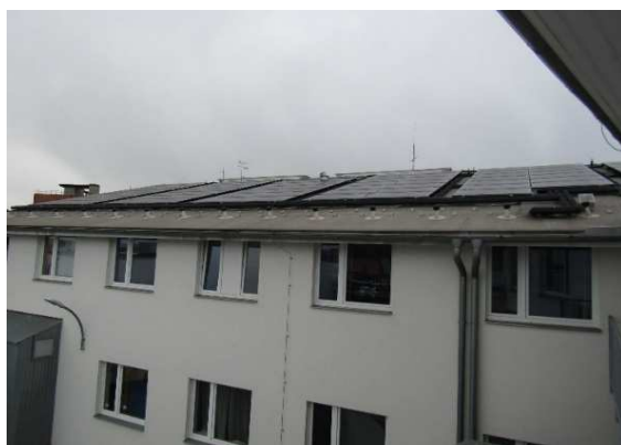
Obr. 8 Schéma zapojení tepelné části a fotografie z instalace nezasklených FVT kolektorů
