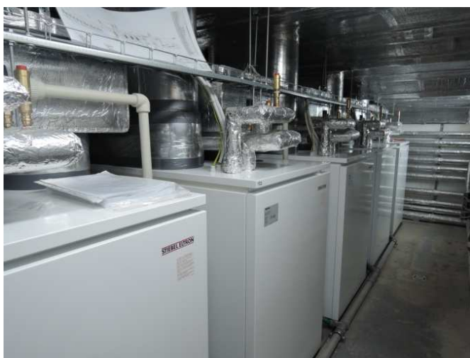
Obr. 4 Tepelná čerpadla WPL 23 a nádrže na teplou vodu SBB 1000WP SOL
