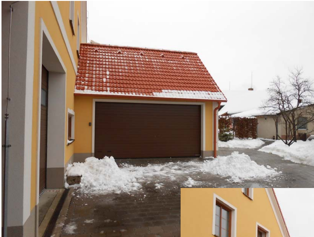
Jižní střecha nad garáží
