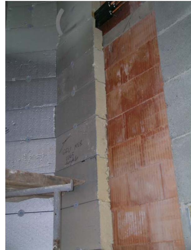
Příprava izolace nádrže
