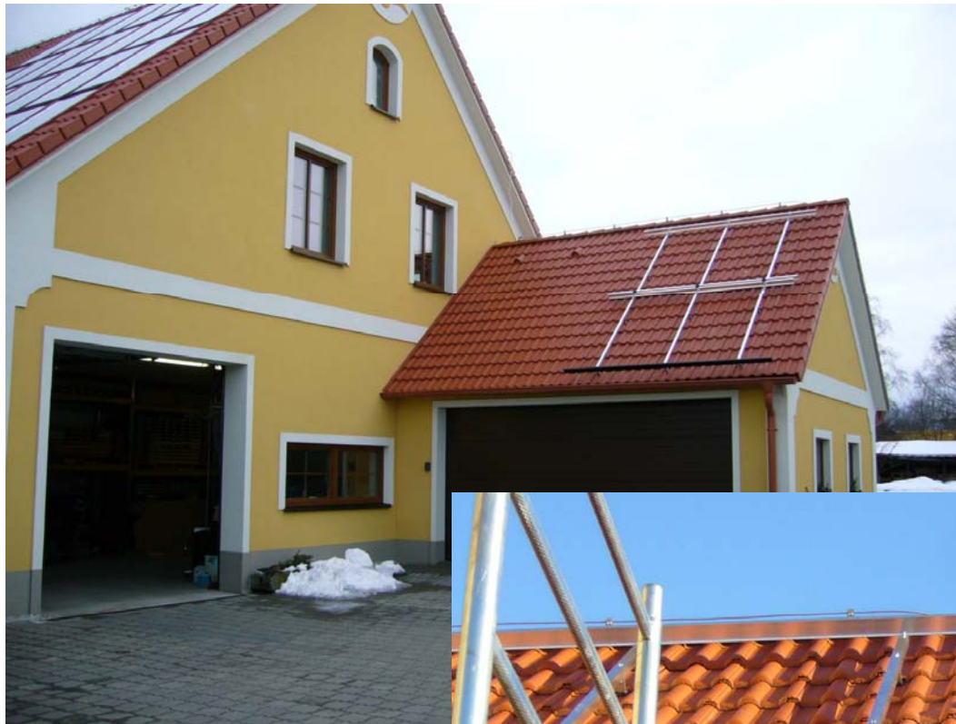
Konstrukce pro uložení kolektorů
