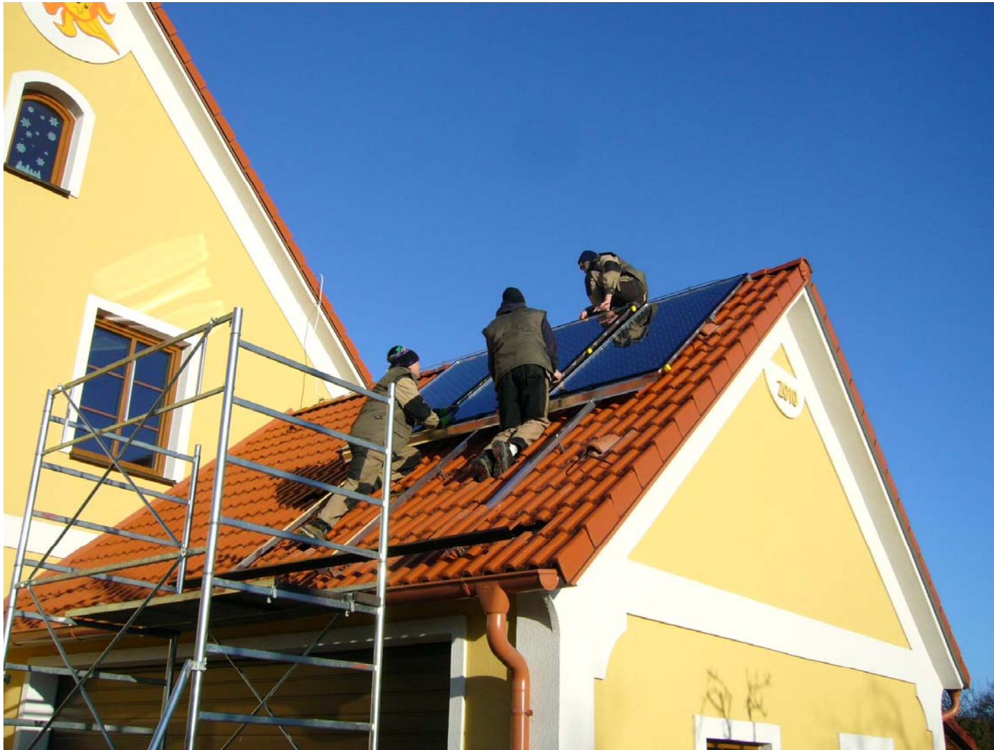
Osazení horní řady kolektorů
